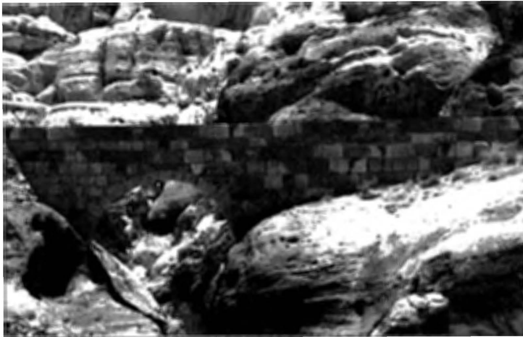
Abb. 7.19 Die Sheb Kes überquerende Bogenbrücke der nördlichen Khubtha-Leitung, Computer-Simulation des ursprünglichen Zustands von U. Bellwald Fig. 7.19 The Sheb Kes arched aqueduct of the northern Khubtha conduit. Computer simulation of the original situation by U. Bellwald
