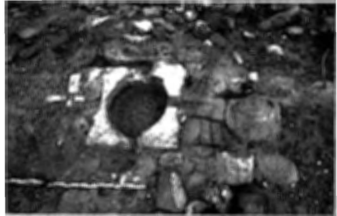
Abb. 7.20 Das am Fuß von Zibb Atuff liegende castellum divisorum der 'Ain-Braq-Leitung
